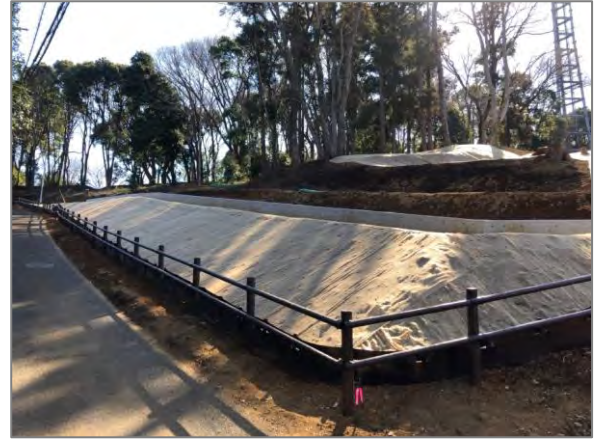
1 保全した樹林地の整備 （菅田町赤坂特別緑地保全地区）
