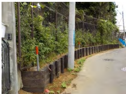
【土留めの設置】 獅子ヶ谷市民の森（鶴見区）
