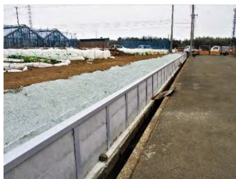
【土留め柵を設置した農地】（都筑区）
