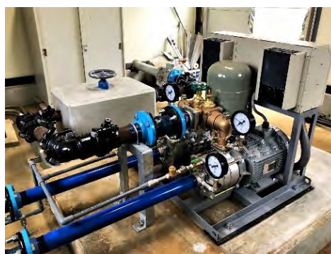
【井戸水の送水設備の更新】（戸塚区）
